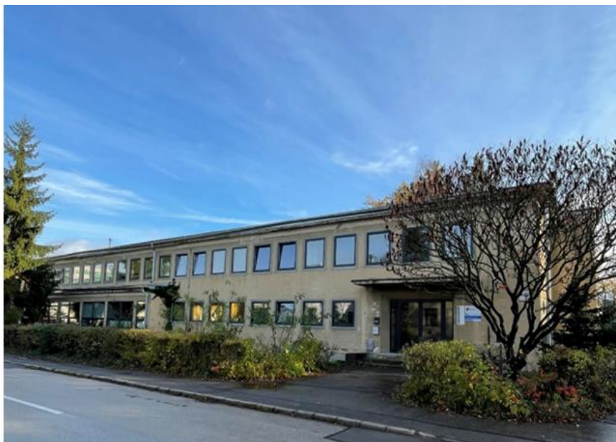
Obr. 17 Priestory spoločnosti - pohľad zvonku
